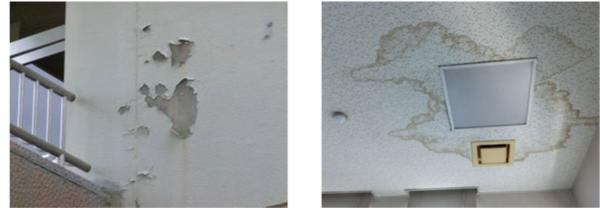
【図表】劣化状況の例（左：外壁塗装の剥離、右：天井の漏水）
