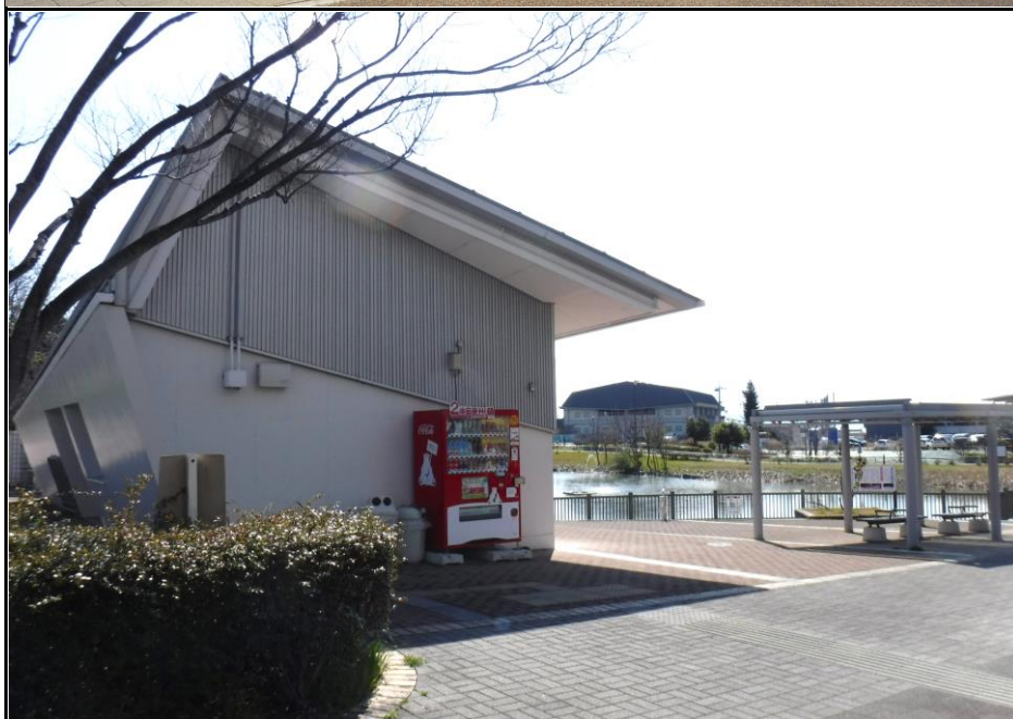
あさぎ里山公園 管理棟
