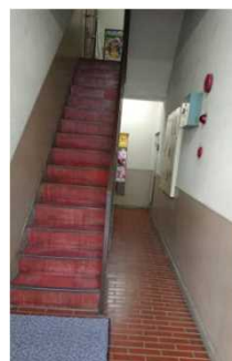
1階エントランスの共用部分
