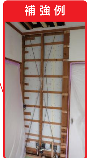
ステンレス製補強金物 壁をステンレス製補強金物で補強しました。
