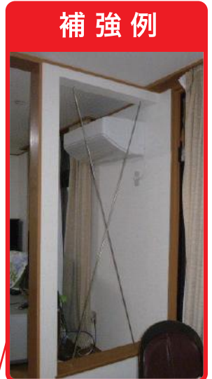
露出仕上げ 部屋を広く見せるため、柱と筋交いを露出した補強を行いました。
