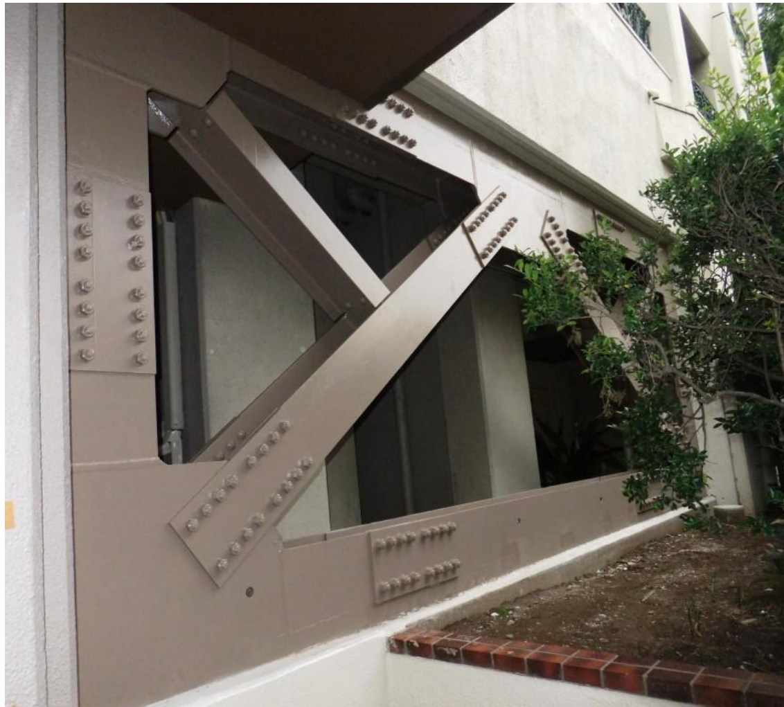
鉄骨ブレースを入れる
