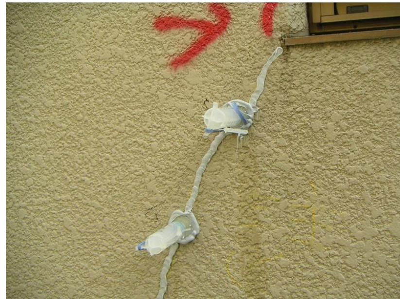
コンクリートのひび割れや浮き、曝裂（バクレツ）部分などの修繕を行う工事です。改修工事では一番基本になる大切な工事です。劣化したコンクリート部分はハツリ取るため、ホコリや騒音が発生します。
