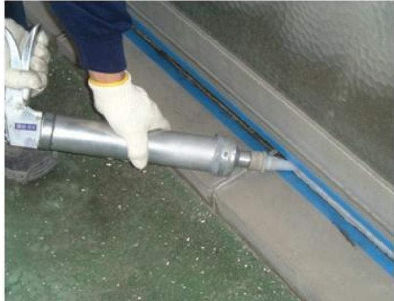
外壁コンクリートの打継目地、タイル目地、サッシ廻りなど、隙間部分のシーリング（防水材）を打ち替える工事で、雨漏りを防ぐために必要な工事です。
