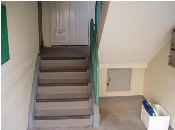
屋上の場合は、アスファルト防水、シート防水、やウレタン防水絶縁工法が多く、バルコニー・廊下・階段は、防滑塗装シート貼が多くなっています。色彩については、デザインしたイメージ写真を複数作成し、アンケートで決めても良いでしょう。
