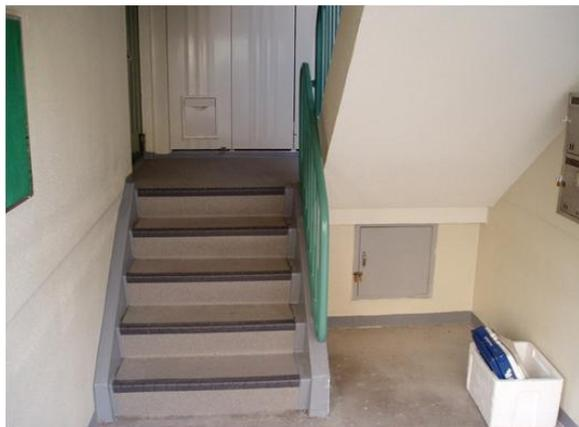
屋上の場合、アスファルト防水、シート防水、やウレタン防水絶縁工法が多く、バルコニー・廊下・階段は、防滑塩ビシート貼が多くなっています。色彩については、デザインしたイメージ写真を複数作成し、アンケートで決めても良いでしょう。
