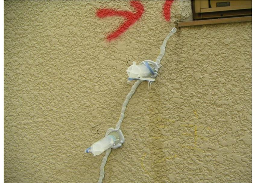
コンクリートのひび割れや浮き、曝裂（バクレッツ）部分などの修繕を行う工事です。改修工事では一番基本になる大切な工事です。劣化したコンクリート部分はハツリ取るため、ホコリや騒音が発生します。
