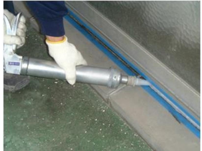
外壁コンクリートの打継目地、タイル目地、サッシ廻りなど、隙間部分のシーリング（防水材）を打ち替える工事で、雨漏りを防ぐために必要な工事です。
