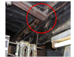
はりの破損、腐食などが発生している
