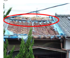
屋根ふき材に剥離、脱落が生じている
