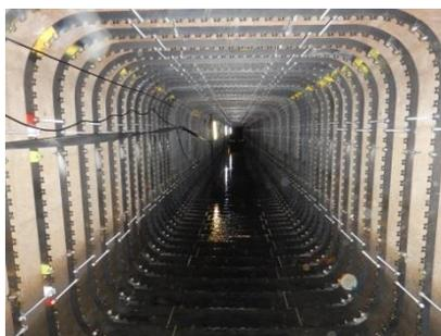
→ 施工中(鋼製リング組立後)
