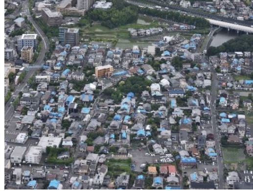
大阪北部地震による被害の様子
