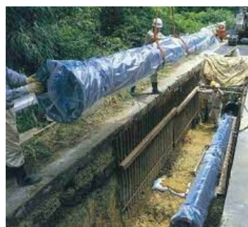
ポリスリーブで保護されたダクトイル鋳鉄管 (出典：日本ダクトイル鉄管協会)
