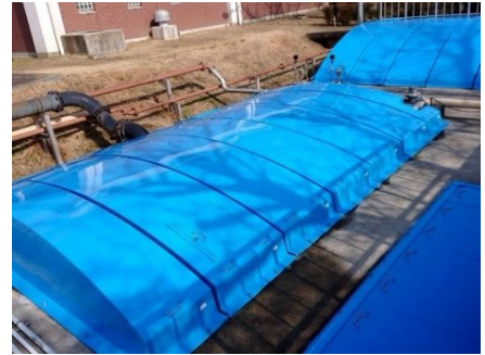
対策一例 覆蓋の設置（十日市浄水場）
