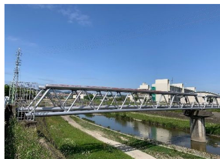
十日市水管橋
