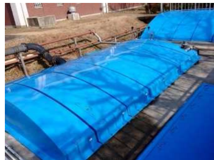
対策一例 覆蓋の設置（十日市浄水場）
