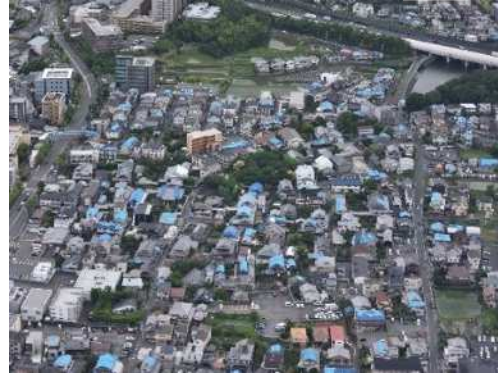
大阪北部地震による被害の様子
