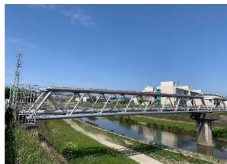
十日市水管橋
