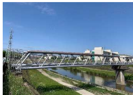
十日市水管橋
