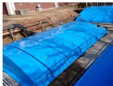
対策一例 覆蓋の設置（十日市浄水場）
