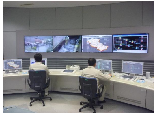
十日市浄水場中央監視室
