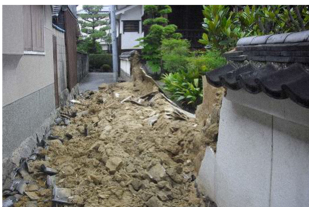
▲道路沿いの土塀の崩壊
