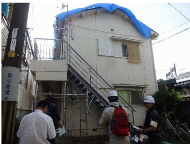
▲ブルーシートで応急処置された住家
