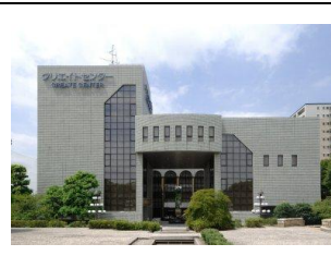
市民総合センター外観
