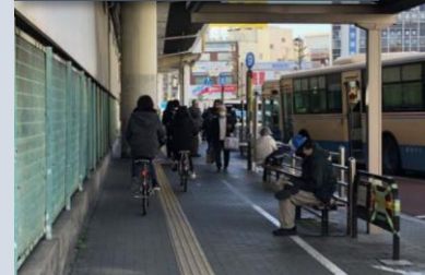
歩道幅員の不足
