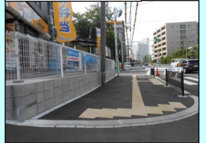
A6 総持寺駅前線・歩道整備
