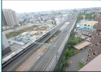
A1 (仮称)JR総持寺駅・整備状況(H28.10)
