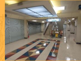
駅前ビルの老朽化・内向き店舗
