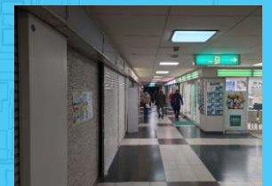
耐震性不足の建物内通路
