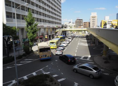
写真：駅前ビル南側道路状況
