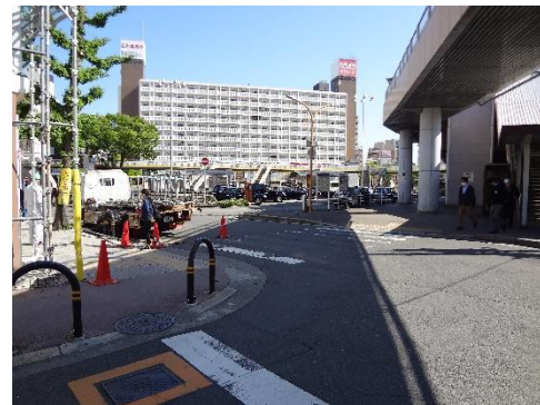
写真：駅西口南側無信号横断歩道
