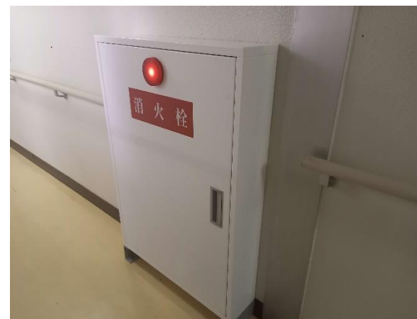
（令和4年度 消火栓設置）
