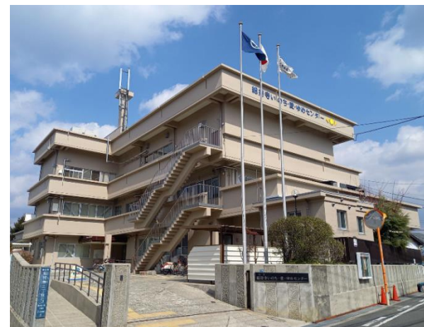
（令和3年度 外壁塗装）
