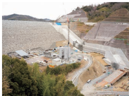
安威川ダム建設工事現場 (大字大門寺)
