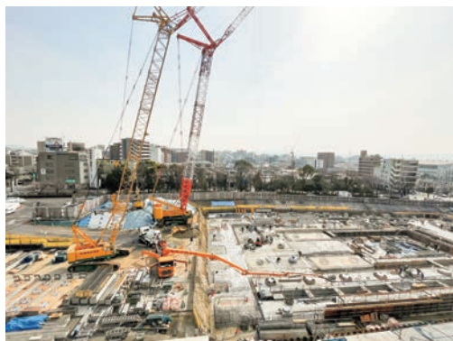
建設中の文化・子育て複合施設「おにクル」
