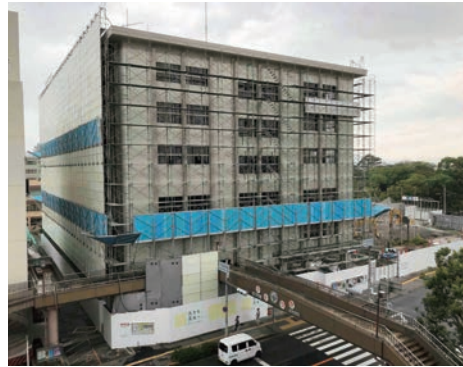
解体工事中の元市民会館（駅前四丁目）
