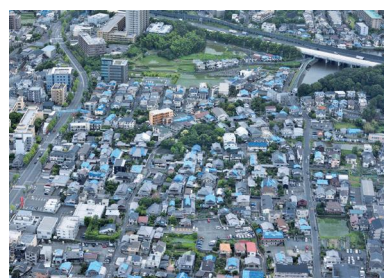
屋根にブルーシートを張った家屋 (中穂横二・三丁目)
