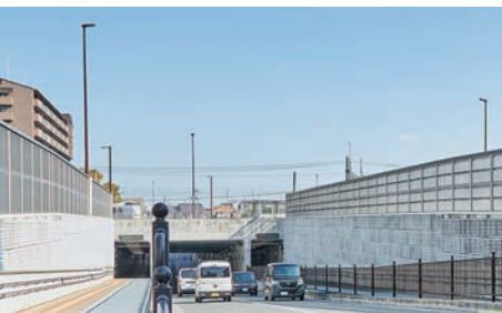
JR茨木駅付近に造った新庄町松ケ本線のアンダーパスは、イオンモール茨木から立命館大学周辺への行き来をスムーズにした
