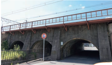
丸また～JR茨木駅間にも内部がレンガの3連トンネル、さらに南にも小さなレンガトンネルが
