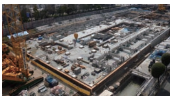
工事が進む建設現場(3月24日撮影)
