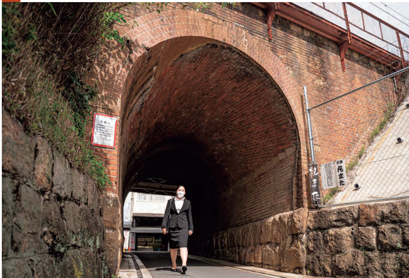
明治9年(1876年)に開通したトンネル 通称「丸また」(上泉町)
