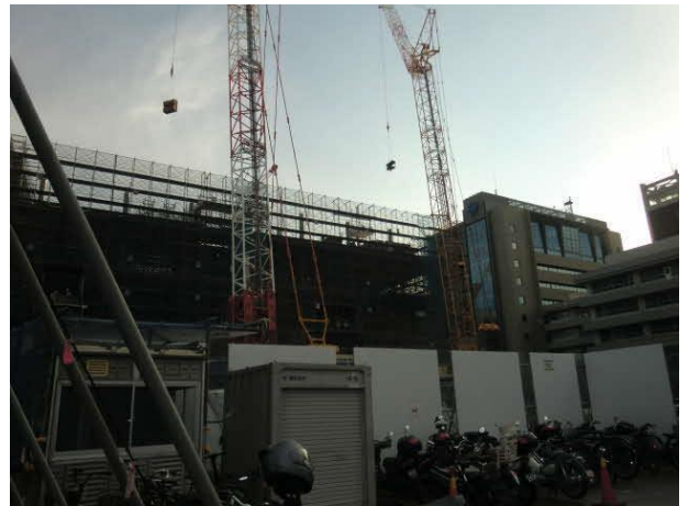
クローラークレーン2台揚重中
