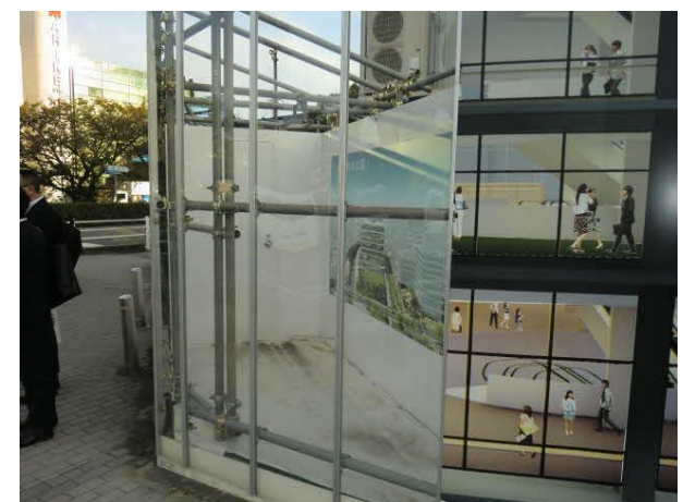
クリアフェンス内側2重仮囲い
