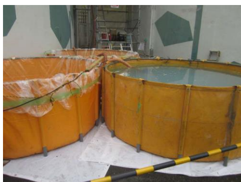
配水池内面除去塗膜処理状況
