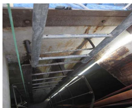
2号配水池内面施工状況
