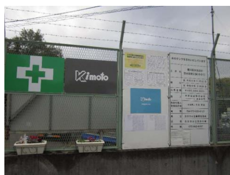
工事掲示板設置
