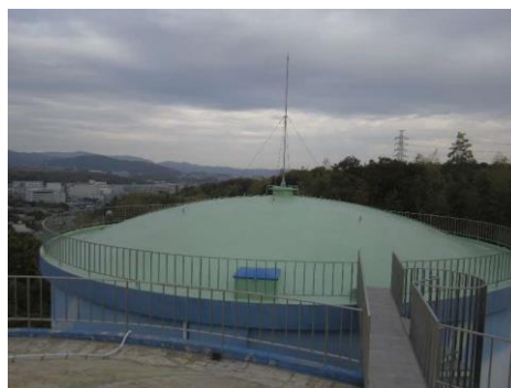
3号配水池屋上防水塗装完了
