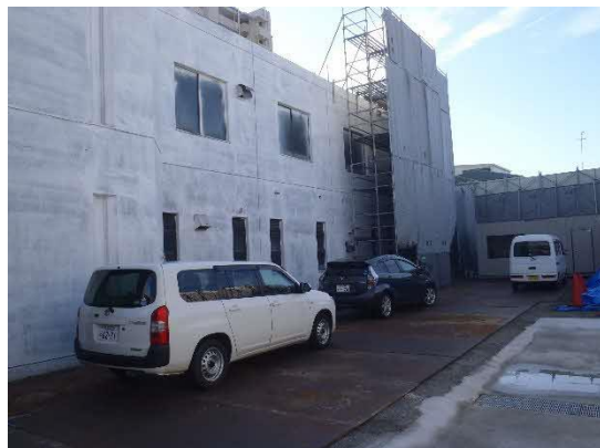
外部 北面 現況
