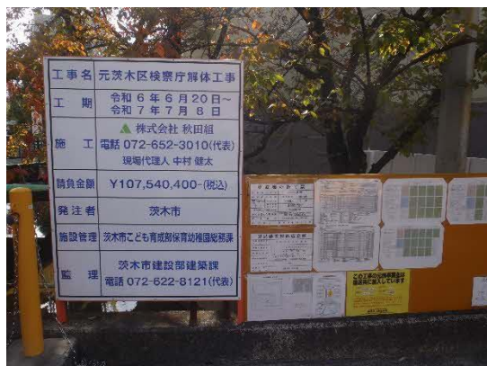
掲示板 建設業許可標識、労災保険関係成立票、施工体系図、建退共標識他
