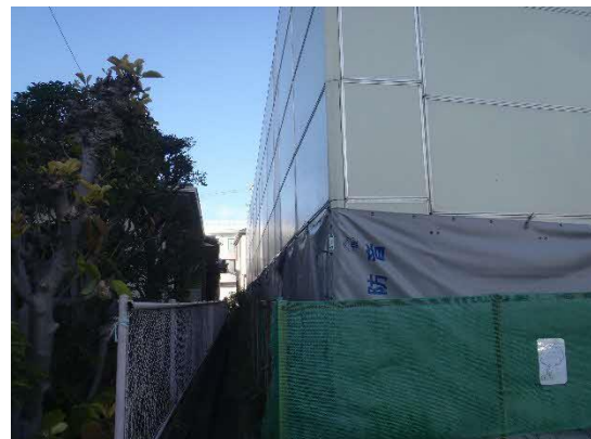
外部 西面 現況
