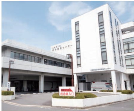
高槻島本夜間休日応急診療所（高槻市南芥川町）
