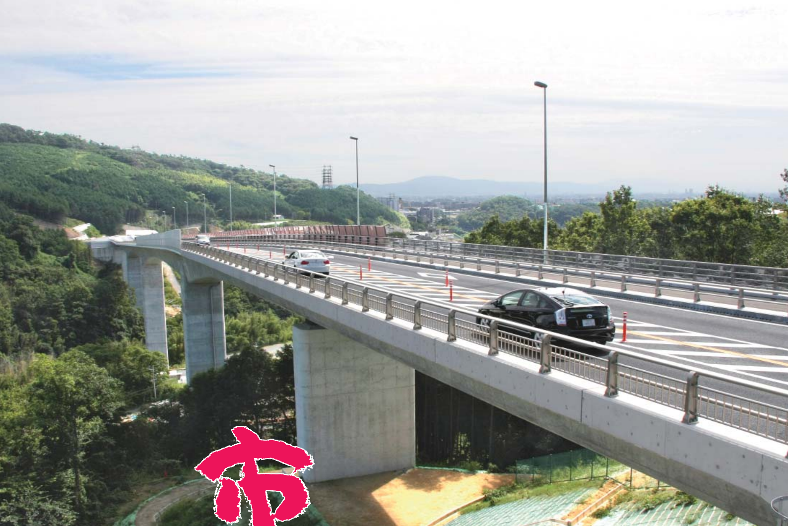
9月25日に開通した府道茨木亀岡線付替道路 [桑原大橋]
