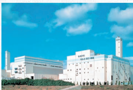
環境衛生センター（東野々宮町）
