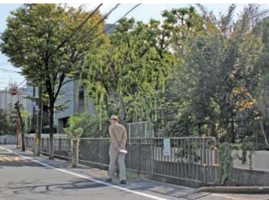
小川水路の改修された安全柵
