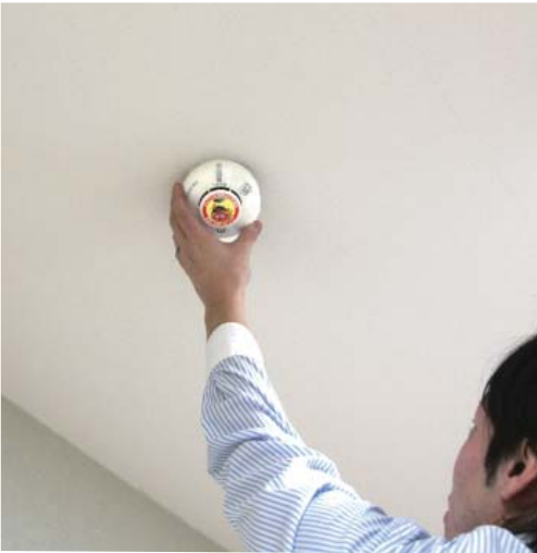
6月1日から設置が義務付けられる住宅用火災警報器
