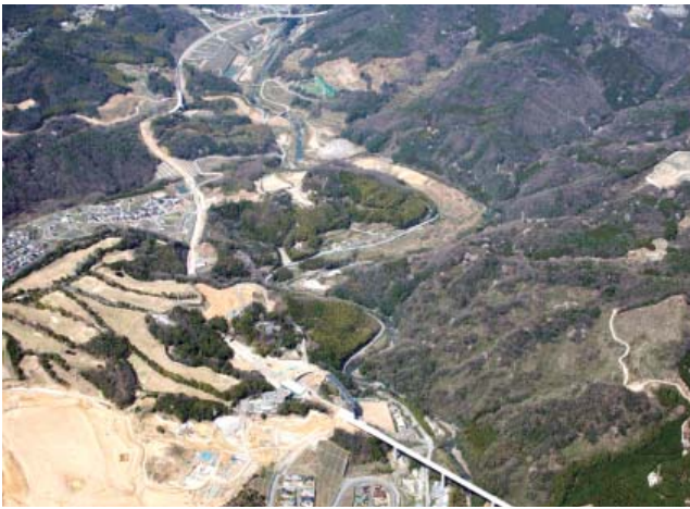
上空から見た安威川ダム建設予定地付近
