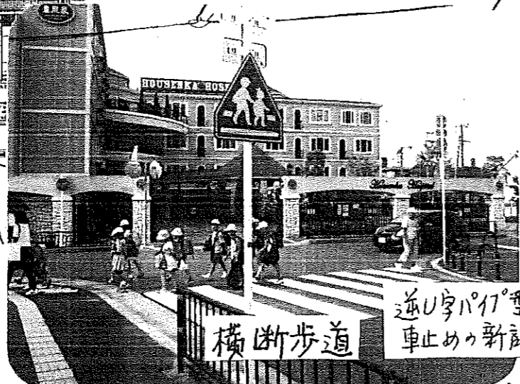
西春日丘3丁目 ほうせんか病院前道路 学校、自治会と登下校を見守って下さっている皆様より、要望があり、実現しました。年々増える交通量に比列して危険度が増えました。横断歩道と車止めの新設により、幅広い年齢層から障害をお持ちの方もこれで安心です。
