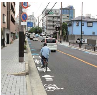
自転車レーンが設置された道路（新庄町付近）
