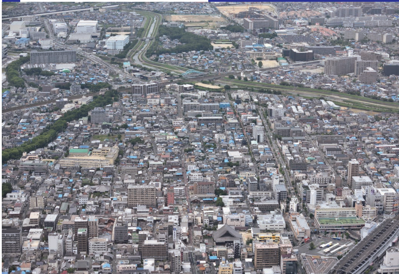
6月18日に発生した地震後の市内(6月27日撮影)
