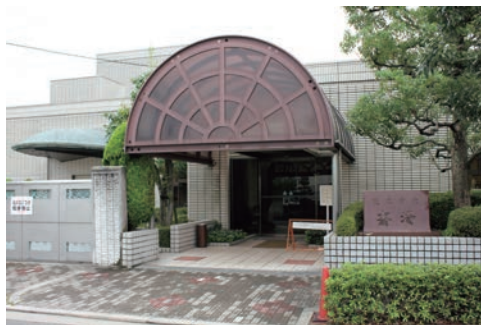
茨木市立斎場の火葬場（大住町）
