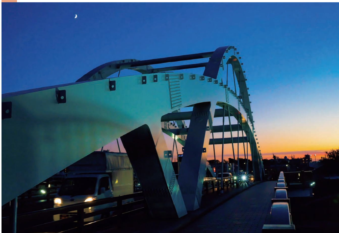
西河原新橋の夕景（西河原一丁目）
