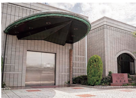
茨木市立斎場の火葬場（大住町）
