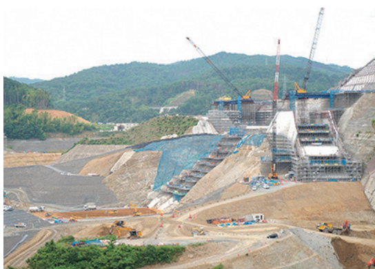
安威川ダム建設工事現場（大字大門寺）
