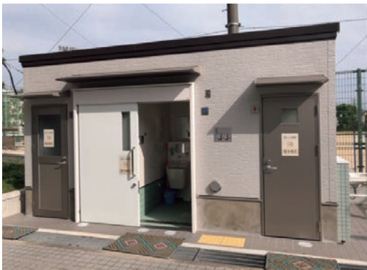
福井運動広場の多目的トイレ（西福井三丁目）
