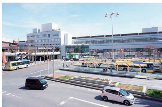
阪急茨木市駅西口周辺（永代町）
