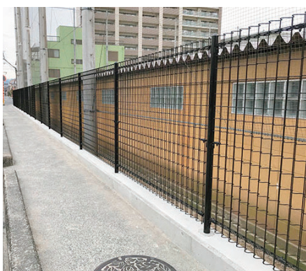
設置されたメッシュフェンス(養精中学校)
