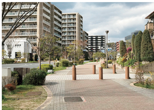
無電柱化された街並み(彩都あさぎ地区)
