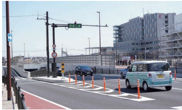
茨木松ヶ本線のアンダーパス（松ヶ本町）
