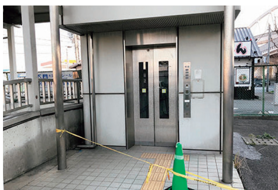
大阪モノレール沢良宜駅西側エレベーター（沢良宜西四丁目）
