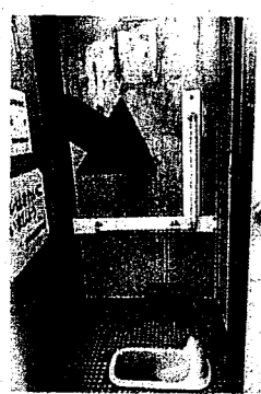
手すり取り付け後
