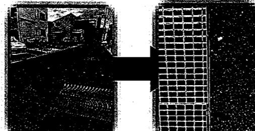
道路上のグレーチング 車両通行時の騒音を防ぐ為、固定
