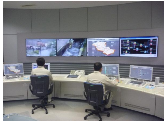
十日市浄水場中央監視室
