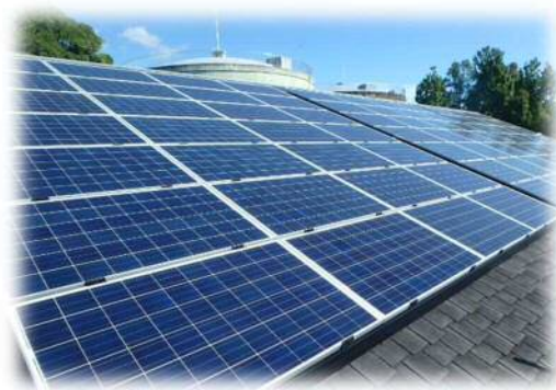
西穂積配水場
