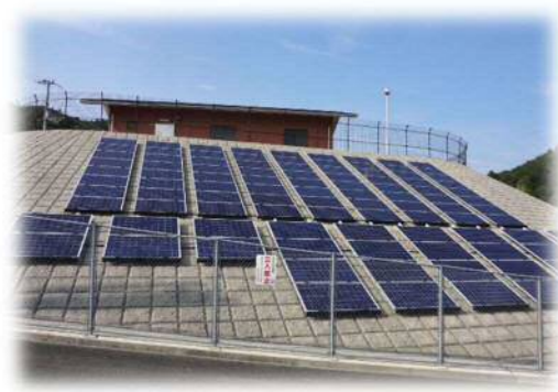
やまぶき高区配水池
