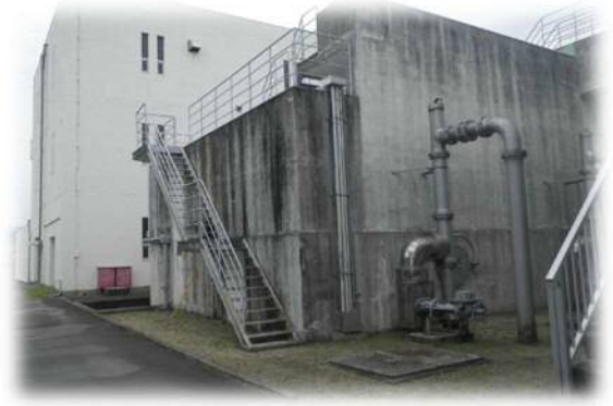
急速ろ過池（十日市浄水場）
