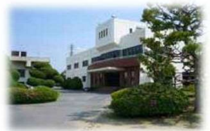
十日市浄水場
