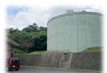
西穂積配水場
